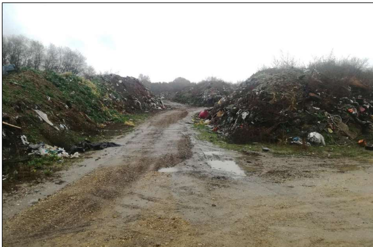
Slika 2.1.-3. Pogled na južnu granicu odlagališta
